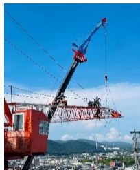
タワークレーン組立て
