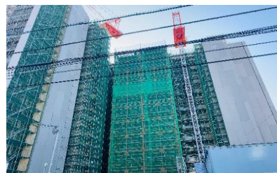
マンション新築工事 外部足場・タワークレーン 工事用エレベータ設置
