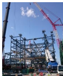
火力発電所新設工事 鉄骨建方
