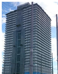
マンション修繕工事 外部足場・工事用エレベータ設置
