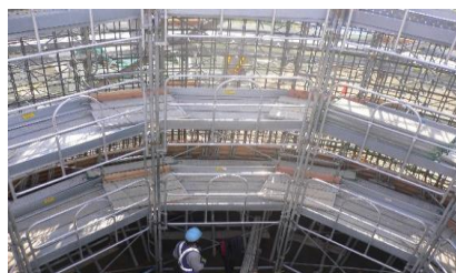
橋梁下部工（7基） 外部足場設置
