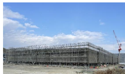
倉庫新築工事 外部足場設置
