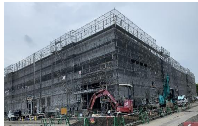
工場新築工事 外部足場設置
