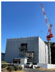
事務所新築工事 外部足場・タワークレーン設置
